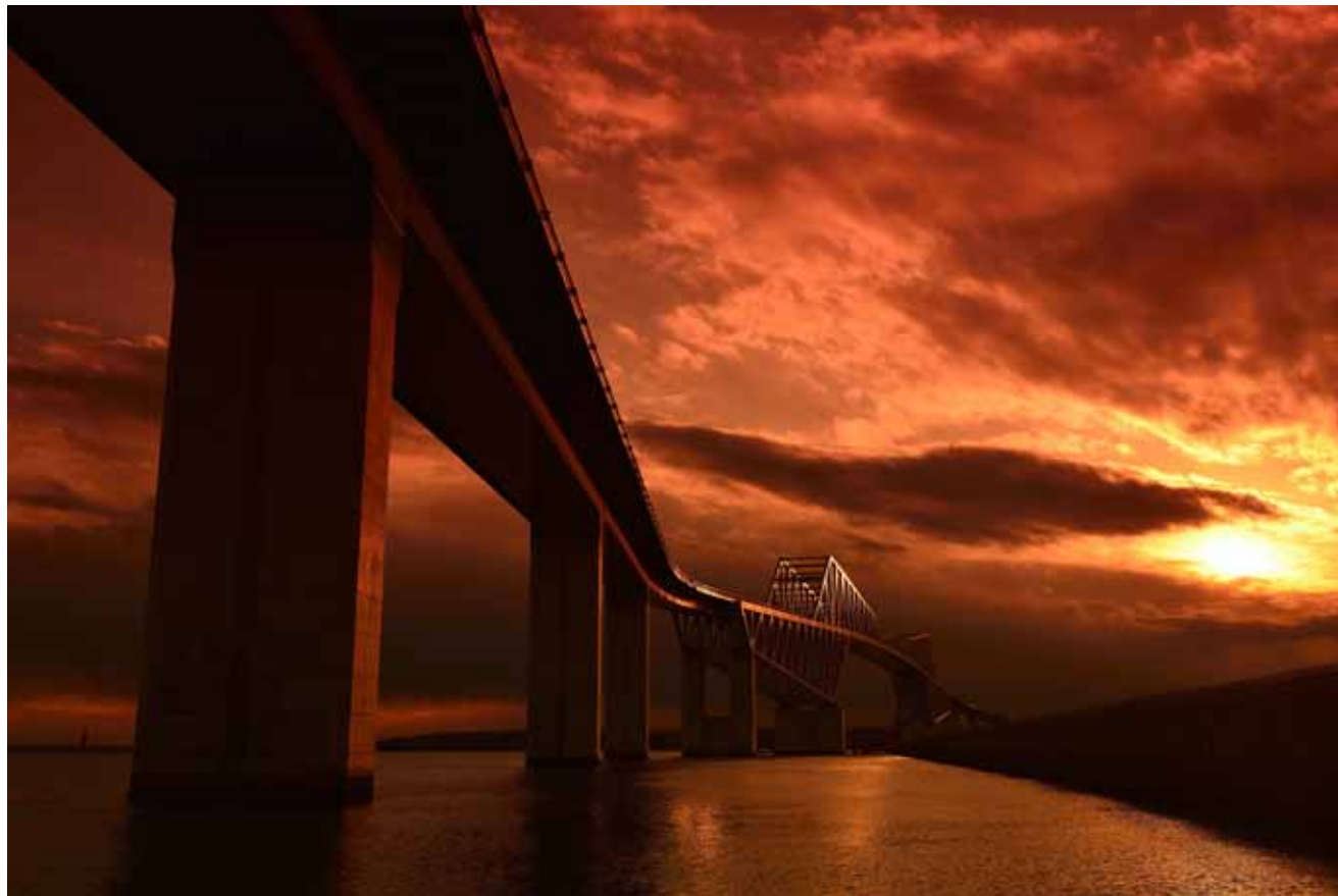
東京ゲートブリッジ
